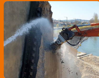
Eine KEMROC-Querschneidkopffräse an der Main-Staustufe Viereth. Im Zuge der Modernisierung erhielten die Betonpfeiler eine neue Formgebung.
