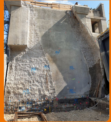
Gesamtansicht des Mittelpfeilers. Oben das ursprüngliche, noch unbehandelte Betonbauwerk, unten der nahezu fertig gefräste Wehrpfeiler.
