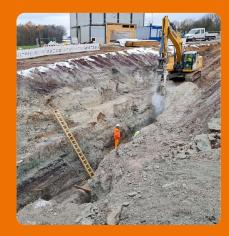
Ein Teilprojekt beim Ausbau der Autobahn A3 in Nordbayern: Auf dem Gelände der Tank- und Rastanlage Steigerwald Süd müssen Entwässerungskanäle verlegt werden.
