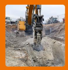
Zum Öffnen des Kanals in felsigem Untergrund mietete das ausführende Unternehmen BUNTE einen 42-t-Bagger zusammen mit einer KEMROC-Kettenfräse EK 150 an.
