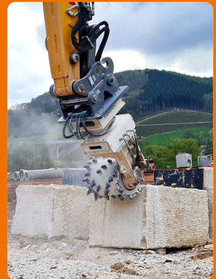
Die Wände der Tunnelportale werden mit mächtigen Blöcken aus Jura-Kalkstein verblendet. Zuvor werden die Blöcke angeschnitten und dann auf die passende Länge gefräst.
