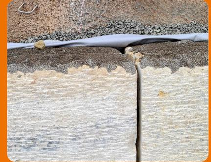
Zwei der rund 9.000 Kalksteinblöcke im Mauerverband. Dank ihrer zentimetergenau gefrästen Länge können die Experten der STRABAG die geforderte Fugtoleranz einhalten.
