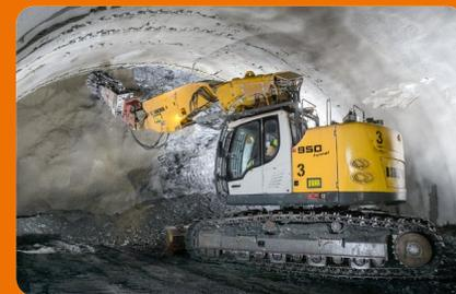
An den Nordhälften eines Schnellstraßentunnels in Polen verwendet PORR einen Tunnelbagger mit einer Kettenfräse zum Auffahren der Tunnelröhren.
