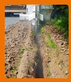
Der entstehende Graben ist sofort fertig für das Einlegen des Glasfaser-Leerrohrs sowie das nachfolgende Absanden, Verfüllen und Verdichten.
