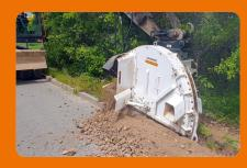
Mit einen KEMROC-Schneidrad SMW 80 am 16-t-Mobilbagger öffnen Tiefbauprofis von Bautechnik Schödl in Schneeberg die Gräben für das Glasfasernetz.
