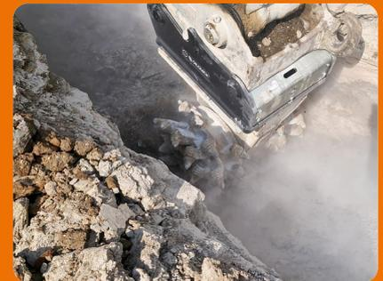
Mit einer KEMROC-Querschneidkopffräse KR150 am firmeneigenen 30-t-Bagger gelang es, die Kanalgräben im harten und überaus zähen Gestein anzulegen.
