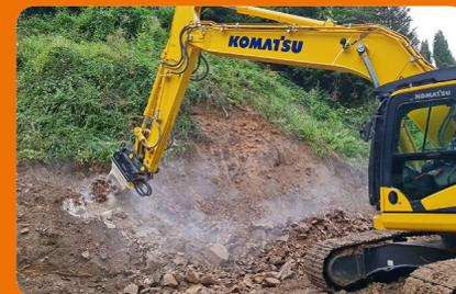
Felswand und Felsboden eines Baugrundstücks entfernten Spezialisten der MH Erdbau GmbH mit einer KEMROC-Querschneidkopfräse KR-D 150 am firmeneigenen 24-t-Bagger.
