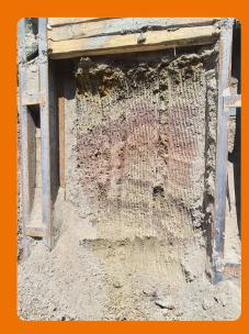
Im kombinierten Einsatz mit dem Rotator hinterlässt die Fräse eine senkrechte, flache Wand ohne Ausbrüche. So bleibt die Menge an Aushub auf ein Mindestmaß beschränkt.
