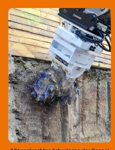
Mit senkrechten Schwüngen der Doppelkopffräse entfernt der Baggerfahrer das Material zwischen den einzelnen U-Profilen, in die später die Verbaubohlen eingezogen werden.
