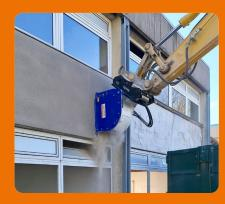
Bei der Sanierung eines Grundschulgebäudes in Gießen verwendete das Unternehmen Leinweber einen Großbagger und eine KEMROC-Flächenfräse EX 60 HD.
