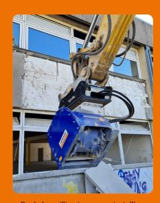
Dank der millimetergenau einstellbaren Frästiefe gelang es, die Vorsatzschale aus Beton sortenrein von der Dämmschicht zu lösen und das Fräsmaterial zu entsorgen.
