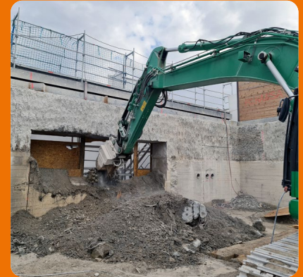
Mannshohe Fensteröffnungen entstanden durch ein dreistufiges Konzept aus der Verwendung einer Seilsäge, der KEMROC-Querschneidkopfräse KR 165 und einer Abbruchschiere.
