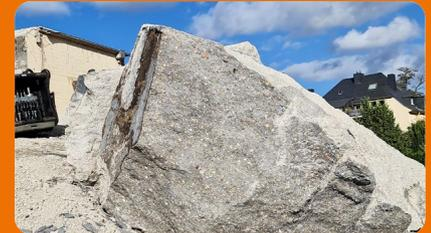
Ein vergleichsweise ungewöhnliches Baumaterial – völlig unbewehrter Beton. Beim Bearbeiten mit einem Hydraulikhammer wäre er strukturell schwer beschädigt worden.
