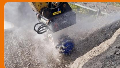
Beim Einsatz der Bagger-Anbaufräse entstanden beträchtlich weniger Vibrationen als beim Einsatz eines Hydraulikhammers.
