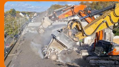
Hydraulikbagger und Frästechnik von KEMROC verwendete das Unternehmen HR-Abbruch in Koblenz. Dort wird ein ehemaliger Hochbunker in einen Wohnkomplex verwandelt.
