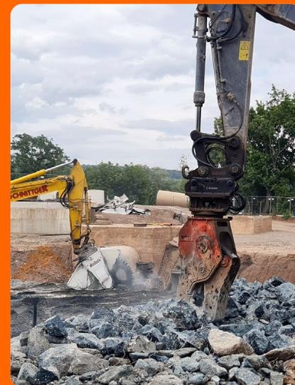
Mit dem Schneidrad und anschließend mit einer Abbruchzange wurde das Betonbauwerk geräusch- und erschütterungsarm und überdies mit hohem Rückbautempo zerkleinert.
