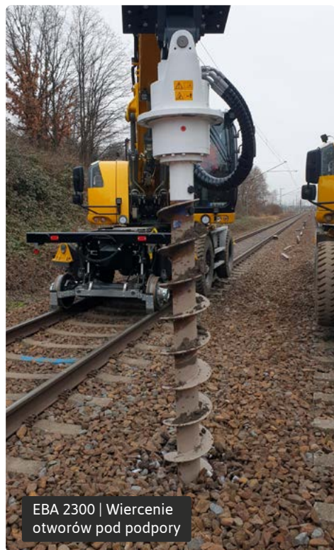
EBA 2300 | Specjalne roboty fundamentowe
