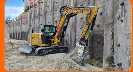
Am Fuß der Bohrpfahlwand wird rundherum ein Drainagegraben geöffnet – zeit- und kostensparend mit einem 9-t-Bagger und einer Kettenfräse EK 40.
