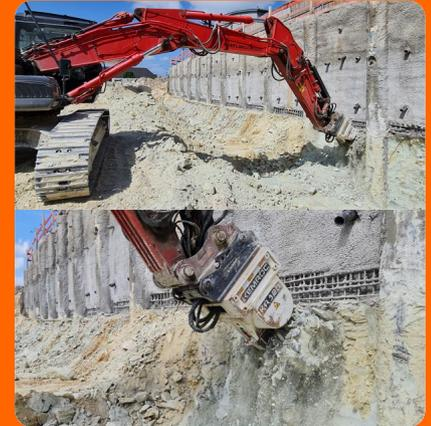
Mit einem 25-t-Kurzheckbagger und einer Querschneidkopffräse KR 120 von KEMROC bereitete das Unternehmen Höfling auf der Baustelle „Königsteiner Höfe“ die Verbauwand für das Auskleiden mit Stahlmatten und Spritzbeton vor.
