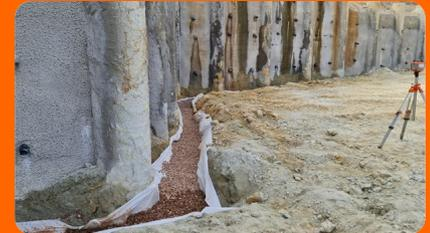
Der Graben wird auf ganzer Länge mit Drainagevlies ausgekleidet und mit Drainagekies verfüllt. So kann eindringendes Regenwasser in Richtung der Pumpenschächte abfließen.
