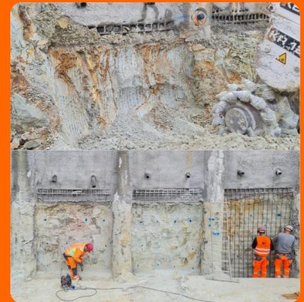
Lage für Lage werden die Flächen aus Quarzitgestein zwischen den Bohrpfählen freigelegt. Nach dem Auskleiden mit Stahlmatten wird Spritzbeton aufgetragen. Der Materialverbrauch ist dabei äußerst gering.
