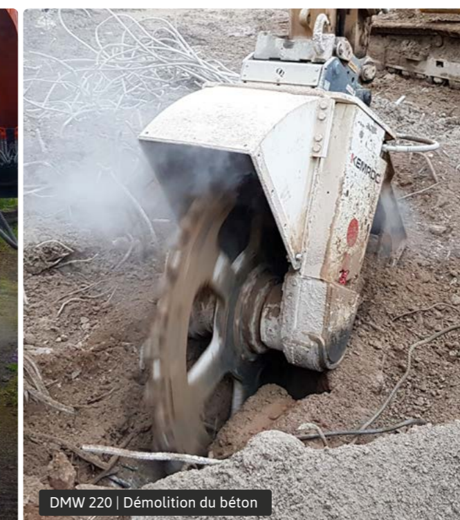
DMW 220 | Creusement de tranchée pour la pose de câble dans la roche de lave
