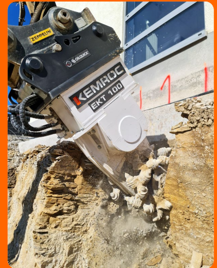
Ohne jegliche Erschütterungen am Gebäude oder Inventar wird unterhalb der Fassade anliegendes Gestein vorsichtig und präzise herausgefräst.
