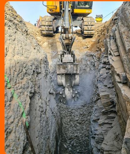
Bis zu 7 m tief wurde der Leitungsgraben in das harte Sedimentgestein hineingefräst. Auf ein seitliches Verschwenken konnte nahezu vollständig verzichtet werden.
