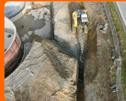
Ein 26-t-Kettenbagger und eine Bullhead-Fräse KRC 140 von KEMROC beim Öffnen eines Leitungsgrabens, der zwei neue Hochbehälter mit dem bestehenden Trinkwassernetz von Neundorf (Thüringen) verbindet.
