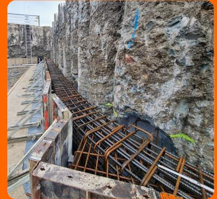
Die Bewehrung des Stahlbetongurts ist hergestellt. Abschnittsweise wird mit Beton verfüllt. Danach steht die Bohrpfahlwand wie aus einem Guss.
