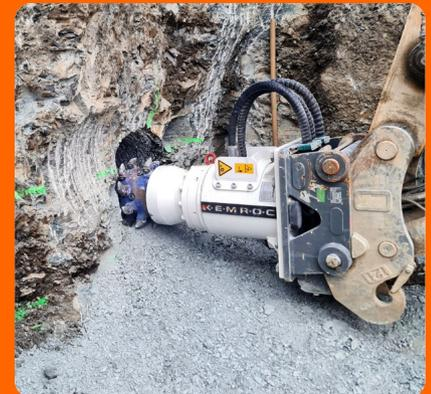
Mit der Fräse werden Vertiefungen in die Bohrpfähle eingebracht. In diese Aussparungen werden Stahlbetonsporne eingegossen. Sie werden später mit einem Stahlbetongurt verbunden, um die Bohrpfahlwand auszusteiern.
