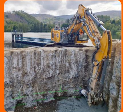
Ein 24-t-Bagger und ein Powertool-Antrieb KRX 70 von KEMROC beim Bearbeiten einer Bohrpfahlwand. Mit Stahlbetongurten versteift, bildet sie den Kern des Staudamms bei der Sösetalvorsperre im Harz.
