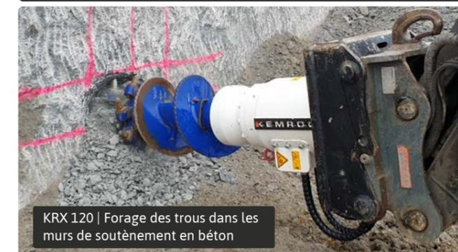
KRX 120 | Forage des trous dans les murs de soutènement en béton
