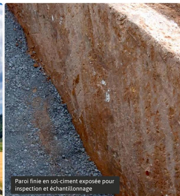
Paroi finie en sol-ciment exposée pour inspection et échantillonnage
