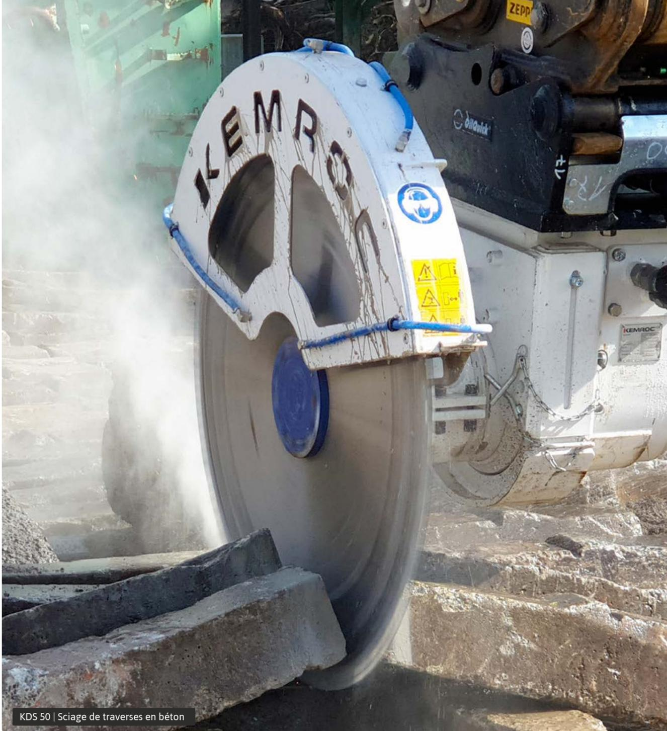
KDS 50 | Sciage de traverses en béton
