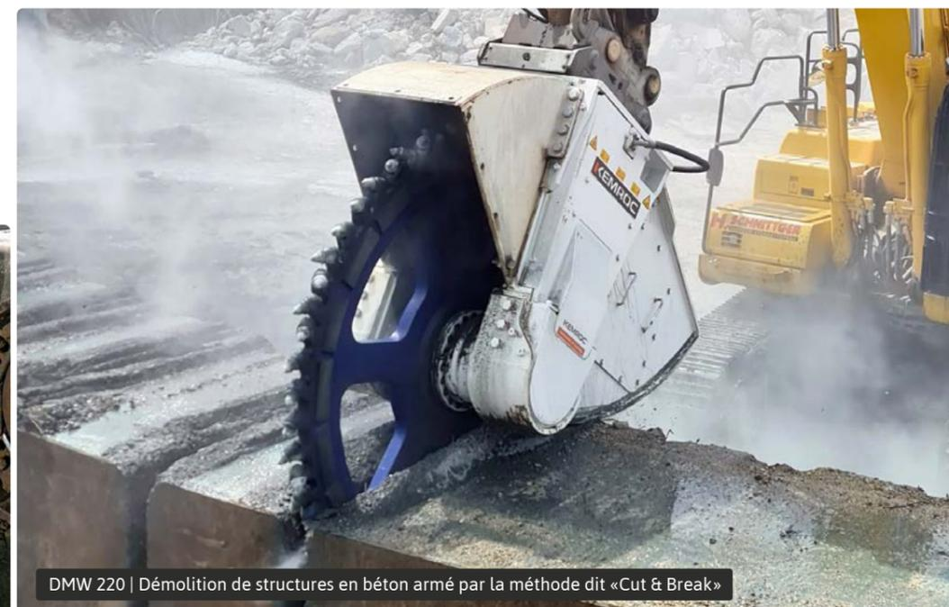
DMW 220 | Démolition de structures en béton armé par la méthode dit «Cut & Break»
