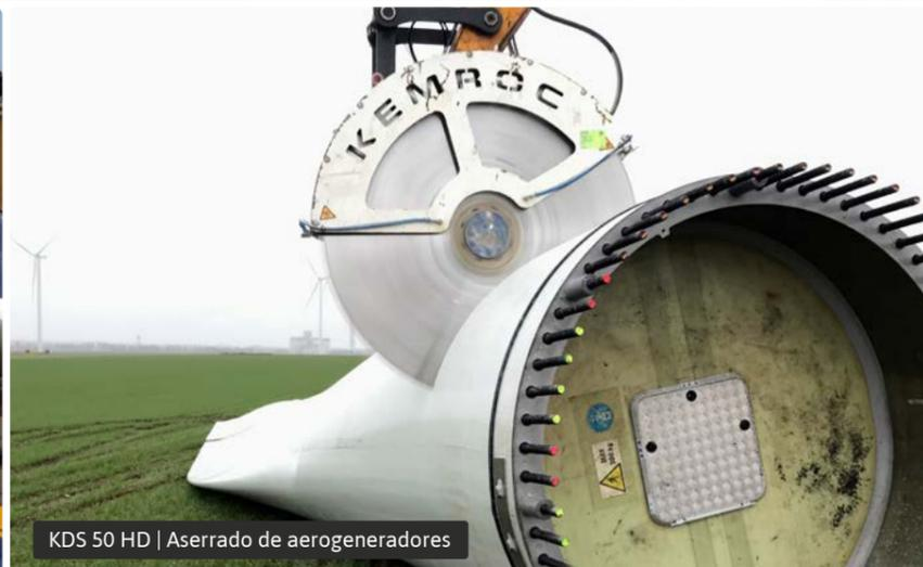
KDS 50 HD | Aserrado de aerogeneradores
