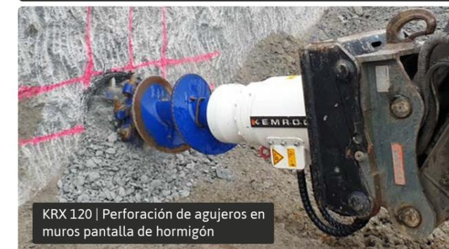
KRX 120 | Perforación de agujeros en muros pantalla de hormigón
