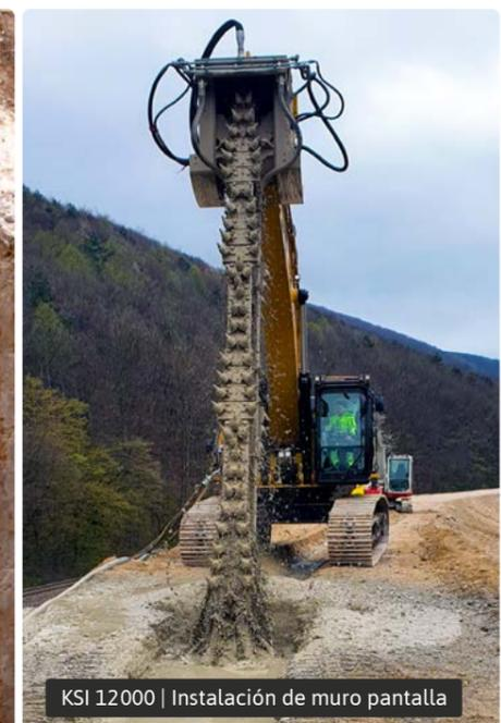
KSI 12000 | Instalación de muro pantalla
