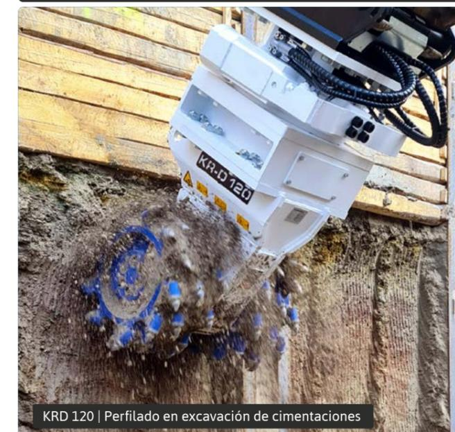
KRD 120 | Perfilado en excavación de cimentaciones
