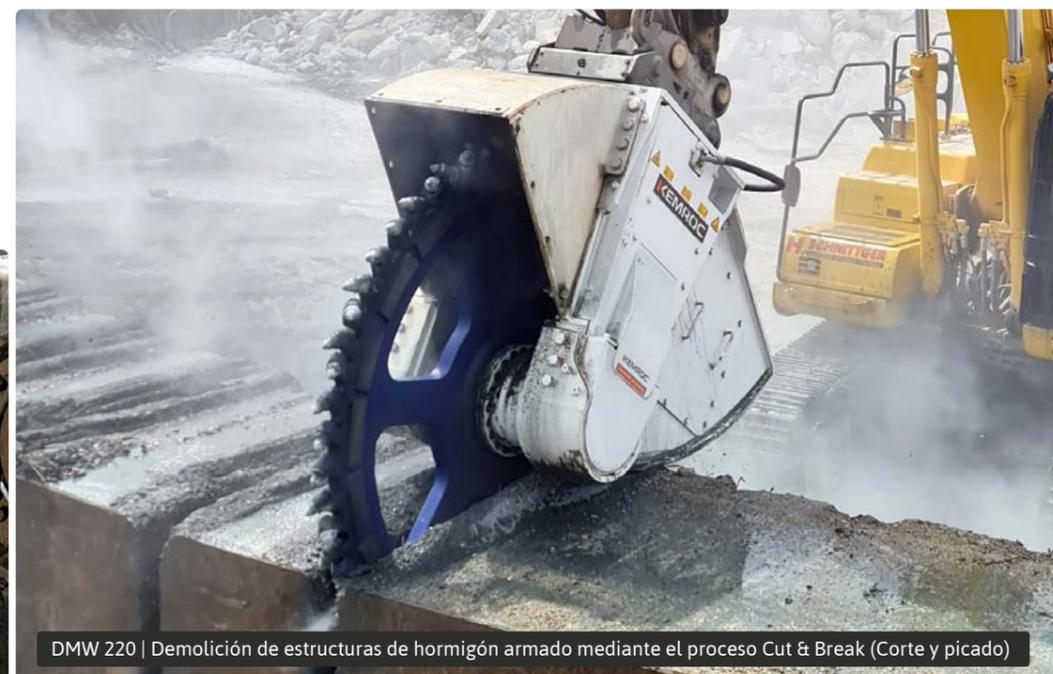
DMW 220 | Demolición de estructuras de hormigón armado mediante el proceso Cut & Break (Corte y picado)
