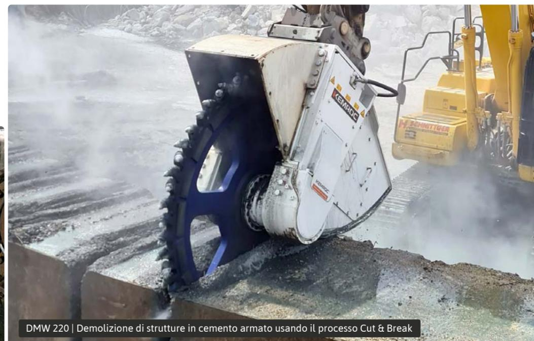
DMW 220 | Demolizione di strutture in cemento armato usando il processo Cut & Break
