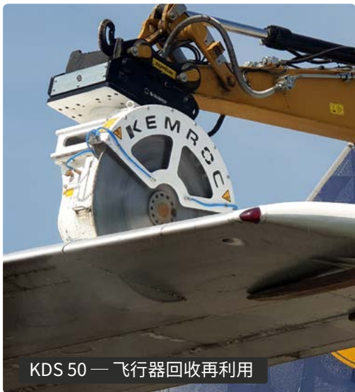
KDS 50 — 切割混凝土
