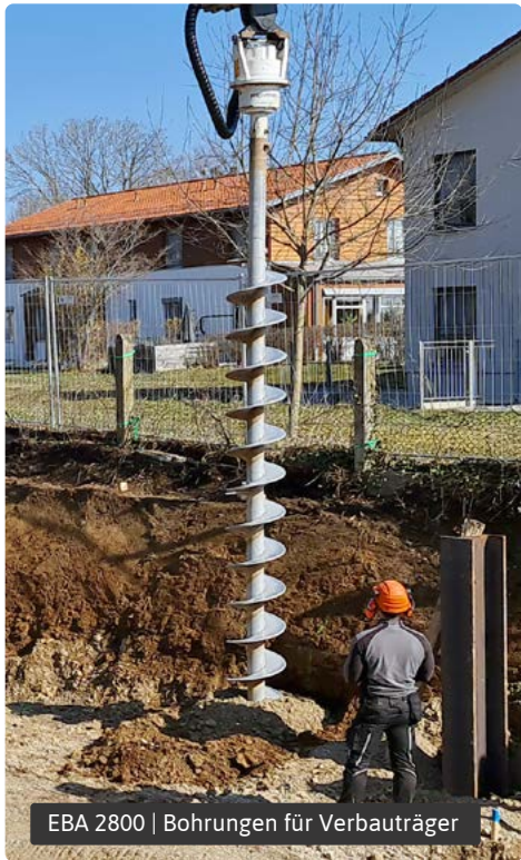
EBA 2300 | Bohrungen für Verbauträger
